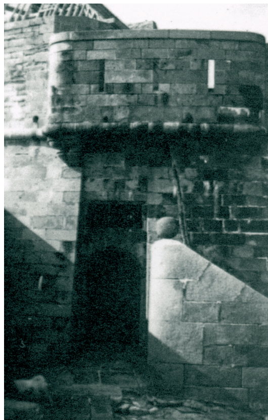
Cette photo prise avant les bombardements de 1944 montre bien le parapet au-dessus de la porte percée de trois meurtrières et dissimulant les mâchicoulis. L'encadrement sculpté et l'échauguette ont été supprimés en 1820 et se trouvent partiellement masqués par le mur latéral de «garantie» et la rambarde de l'escalier.
